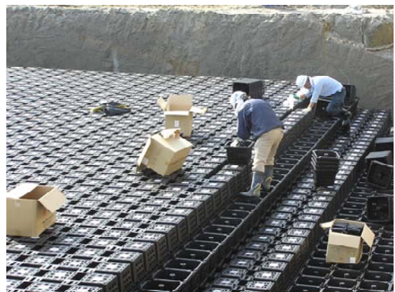
雨水貯留浸透施設（設置作業）
