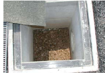
透水性舗装と浸透ます
