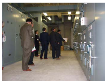
筑紫地区 現地調査
